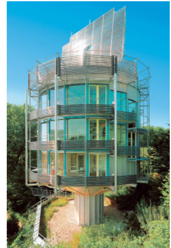
Das erste Haus, das sich mit der Sonne dreht: „Heliotroph“ von Architekt Rolf Disch/Freiburg
