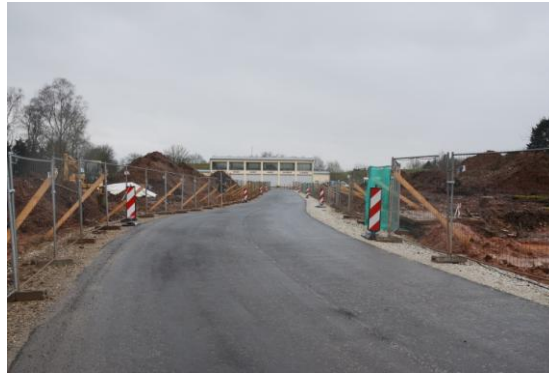
Straße für öffentlichen Verkehr während der Arbeiten
