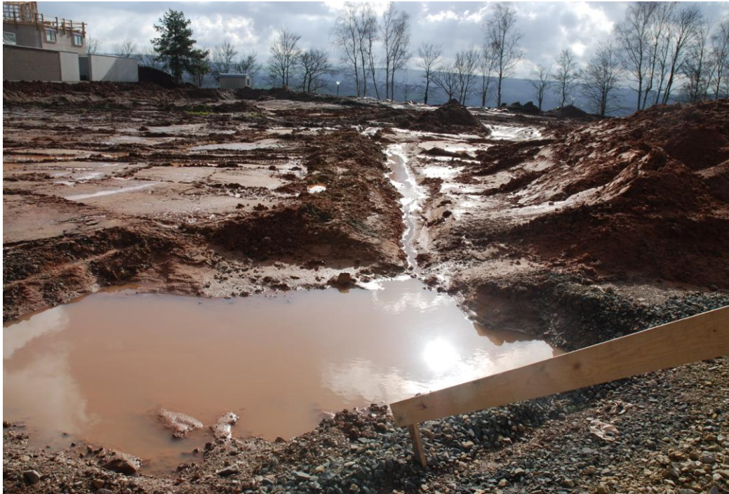
Bodenverhältnisse nach Niederschlagsereignis
