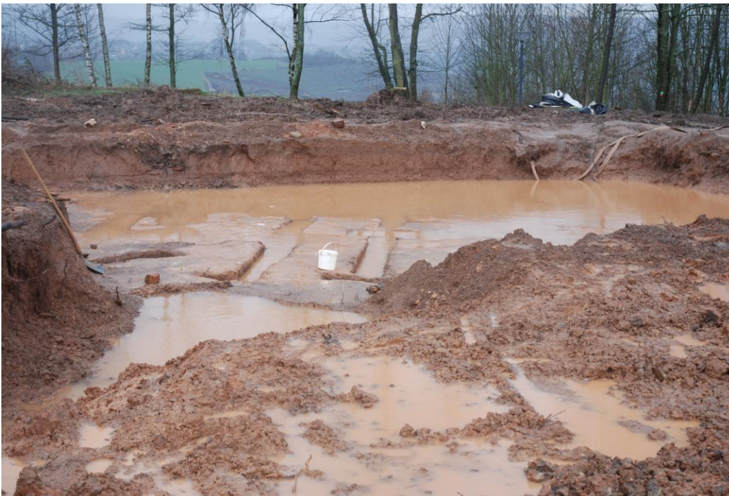
Bodenverhältnisse nach Niederschlagsereignis
